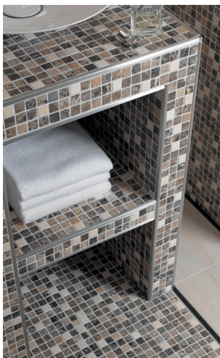
Squareline : profilé de finition carré en aluminium
